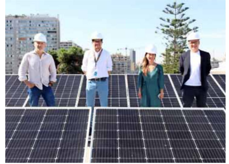
Paneles solares en el emblemático edificio de Alonso de Ovalle.
